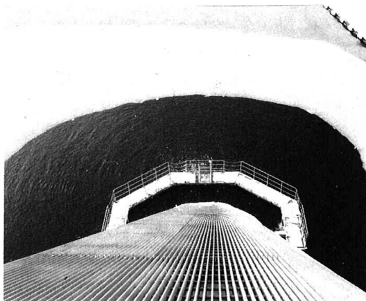
流木流入防止装置前面解氷状況
