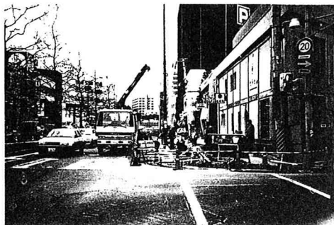
写真-1 車線規制による施工状況
