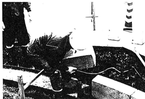
写真-2 人力による据付施工状況
