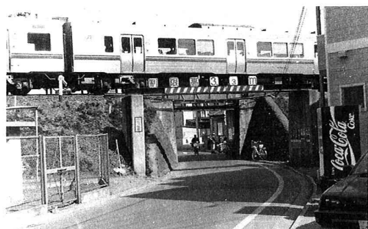
写真－ 1 仙山線東照宮駅下の軌道跡
