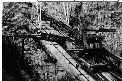
写真-1、自走式S・Pによるシュート部打設
