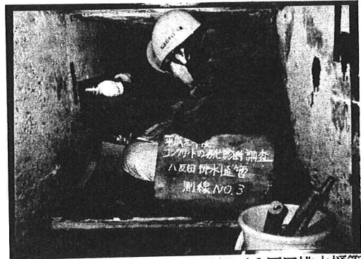
写真-2 屈折法による測定状況 (八反田排水樋管)
