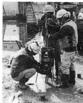
写-2 破砕剤充填状況
