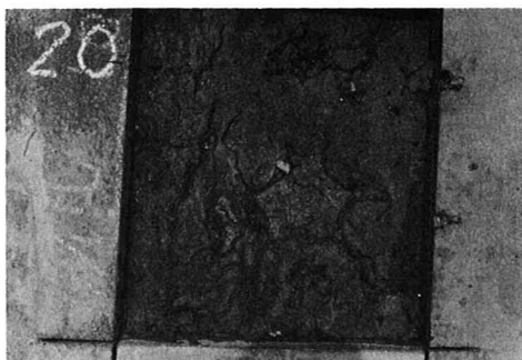
写真-3 ソイルセメントを取除いた状態
