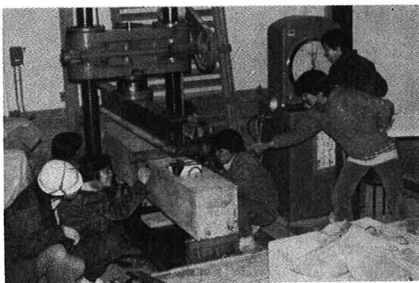
写真-1 載荷装置
