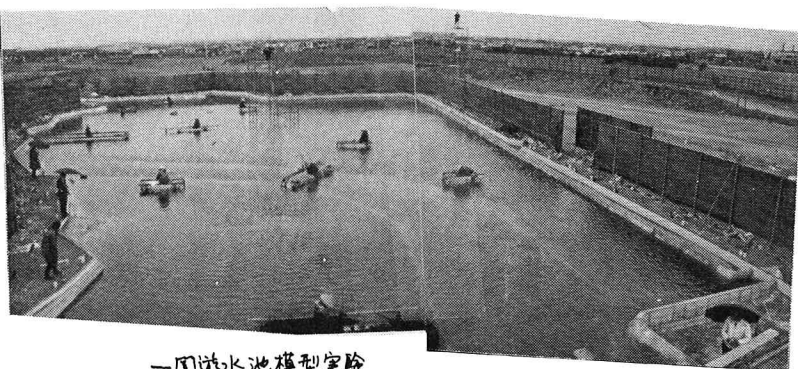
一岡遊水池模型実験 (上流側より下流側を見る。)
