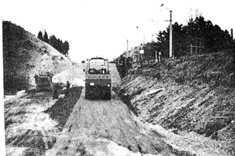
写真-1 盛土転圧作業
