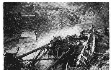
中の橋、オニ荒川橋梁トラス
