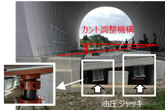
図-7 トンネルスラブの可変装置
