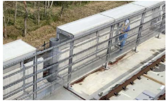
図-6 仮設線路防護柵
