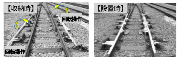
図-2 可動式横取り装置(横取り器(前))
