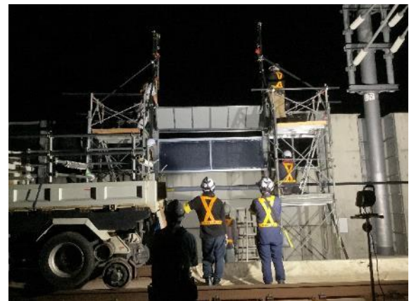
図-1 防音壁取替施工例
