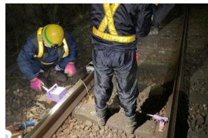
図-3 道床横抵抗力の測定状況
