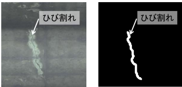
図-3 学習用データのサンプル (ひび割れ)
