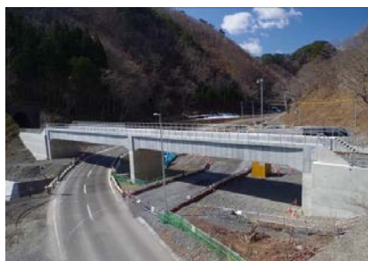
図-3 SRC-GRS 一体橋梁 三陸鉄道 ハイベ沢 B
