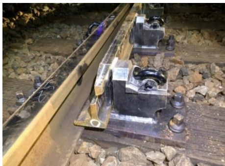
(a) ボルトレスガード敷設後
