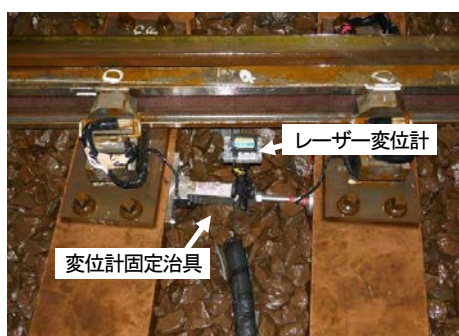
図-21 レーザー変位計の設置方法
