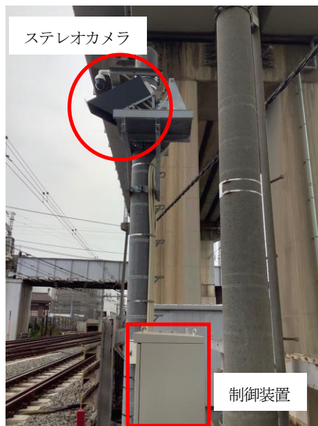
図-8 特殊分岐器ふく進測定装置
