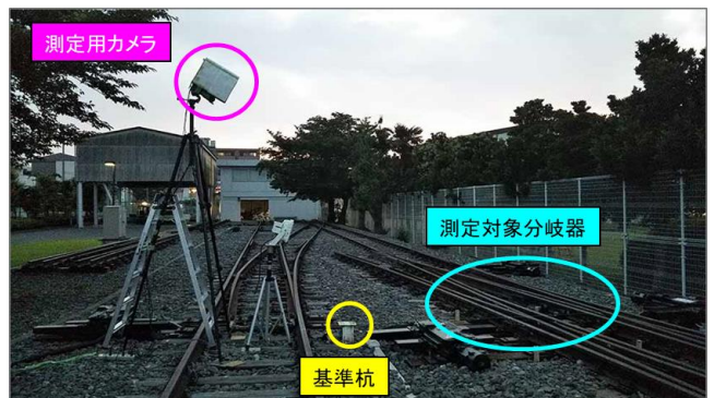
図-4 実験線試験状況
