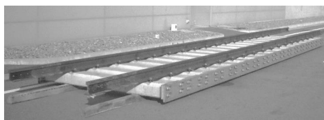
図-10 まくらぎ連結工（バラストがない仮組状態）
