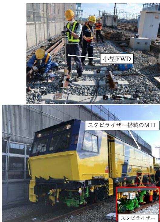
図-7 MITによる作業状況
