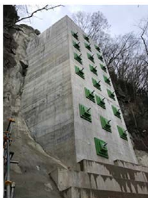
図-12 対策後の状況
