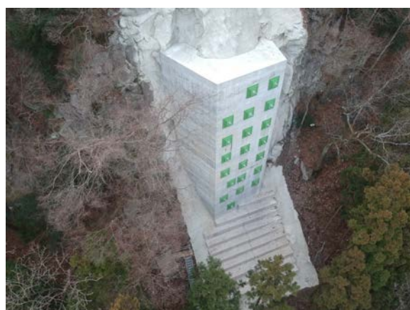
図-18 完了状況俯瞰
