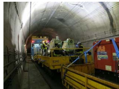
図-4 実トンネルでの騒音・振動測定状況
