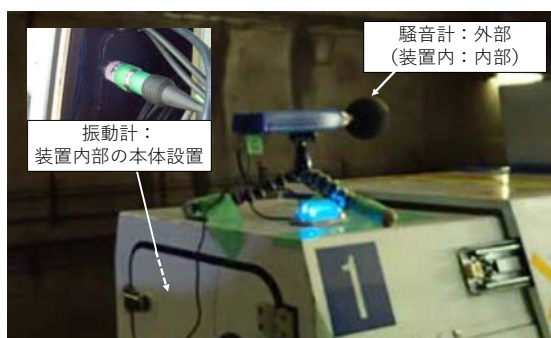
図-5 振動計，騒音計設置状況
