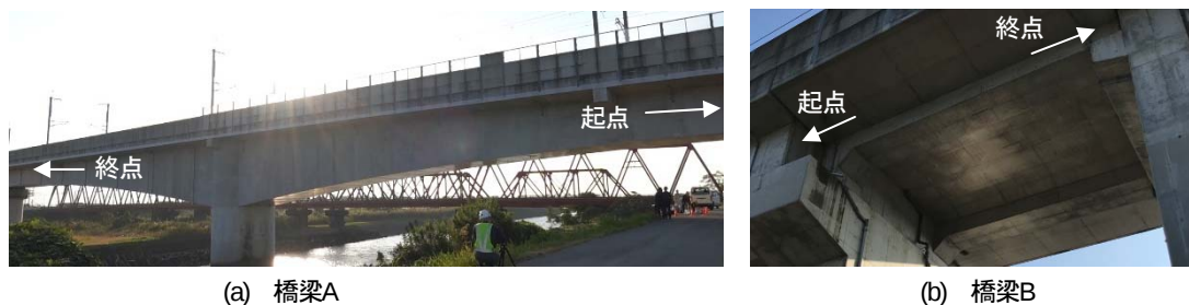
図-2 対象橋梁の写真
