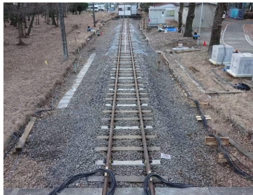
図-2 実物大試験軌道の写真
