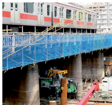
図-2 回転切削圧入工法の鉄道構造物への適用例 6)
