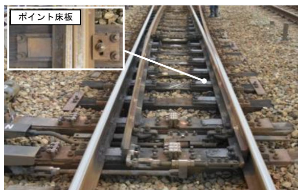
図-1 分岐器ポイント部
