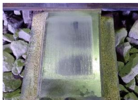
図-21 転換試験(102万回)後の外観
