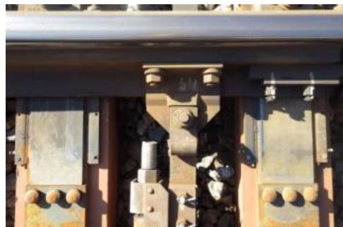
図-23 敷設後の外観状態
