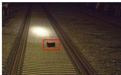
写真-3 機械学習した支障物
