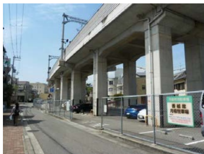
図-4 高架橋区間の例（阪神電鉄本線）
