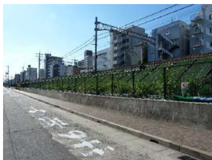
図-3 鉄道盛土の状況
