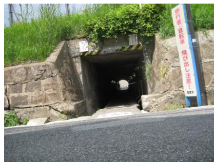
図-5 西宮市のレンガトンネル（マンボウトンネル）
