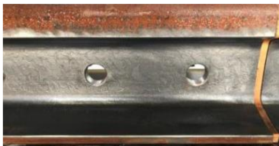
図-4 3種ケレン施工後の表面状態
