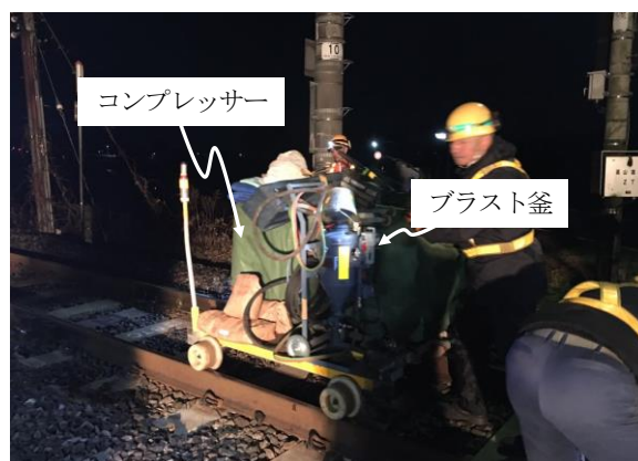
図-12 小型ブラスト機材の運搬状況
