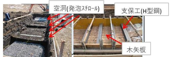
図-2 試験設備内部の埋設物の状況
