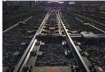
図-8 低廉型次世代分岐器の営業線敷設状況
