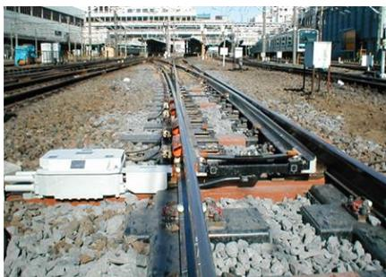
図-1 次世代分岐器(2000型)
