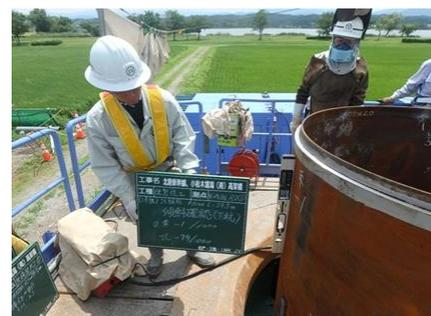
写真-4 デジタル傾斜計による傾斜確認
