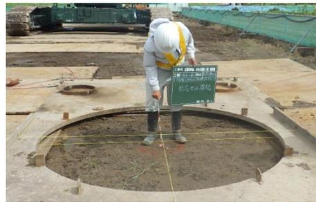
写真-2 斜杭の杭芯セット状況
