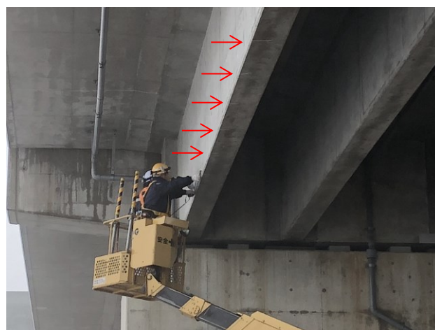
図-6 特別全般検査従来法での1mピッチのメモリ記入(矢印の先のチョーク痕)
