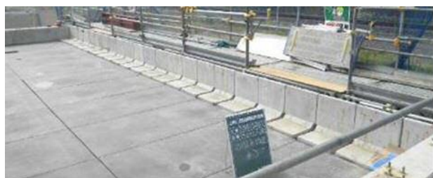
図-3 バラスト止め設置状況
