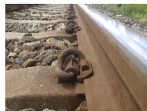
図-2 線ばね系レール締結装置
