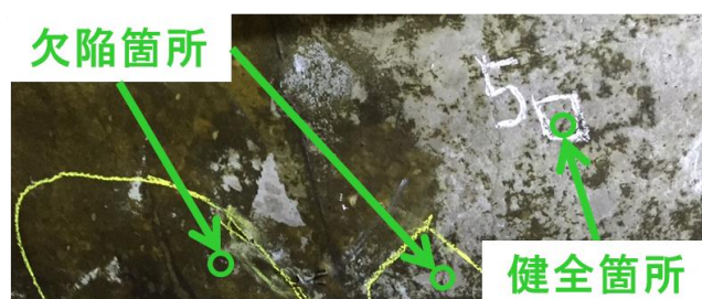
図-13 鉄筋コンクリート覆工トンネルの試験箇所
