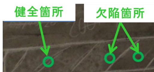
図-14 無筋コンクリート覆工トンネルの試験箇所
