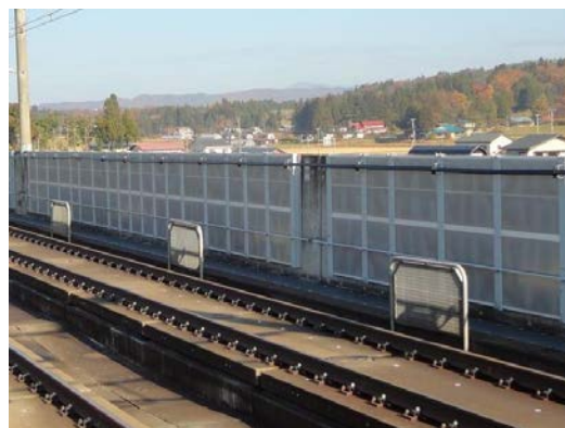
図-7 取付け面積を改善した内張り吸音材の状況
