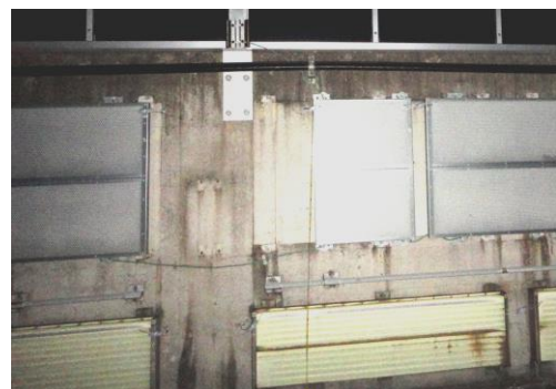
図-1 高架橋内部の付帯物の状況の例
