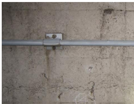
図-3 高架橋防音壁に取付けられた保守用手摺
