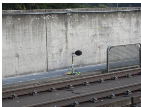
図-9 高架橋内部のマイクロフォン設置状況
