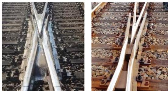
図-1 マンガンクロッシング(左)とレール製クロッシング(右)
