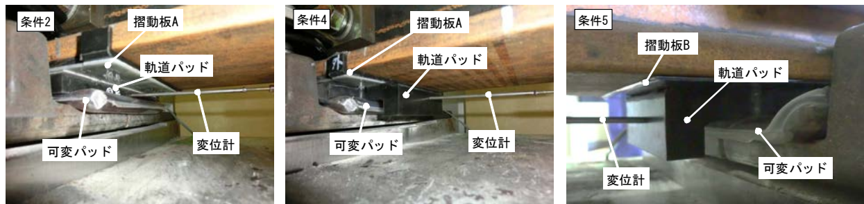
図-7 対策工導入条件での各部材設置状況
