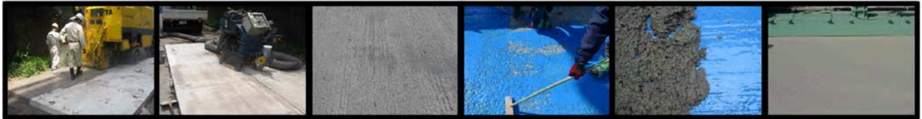
1) 供試体表面の切削      2) 研掃機による表面仕上げ      3) 研掃後      4) 接着剤の塗布      5) SFRC 上面増厚      6) 仕上げ
