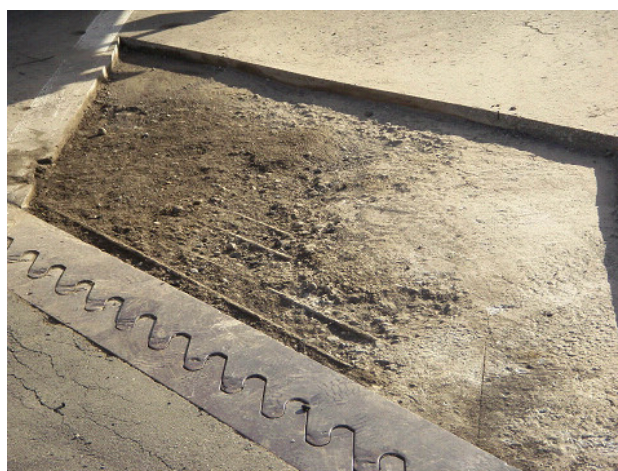
写真-2 RC 床版上面の砂利化現象
