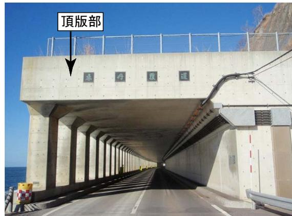
写真-1 落石覆工頂版部の例
