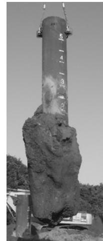
図-5 築造した根固め部状況
