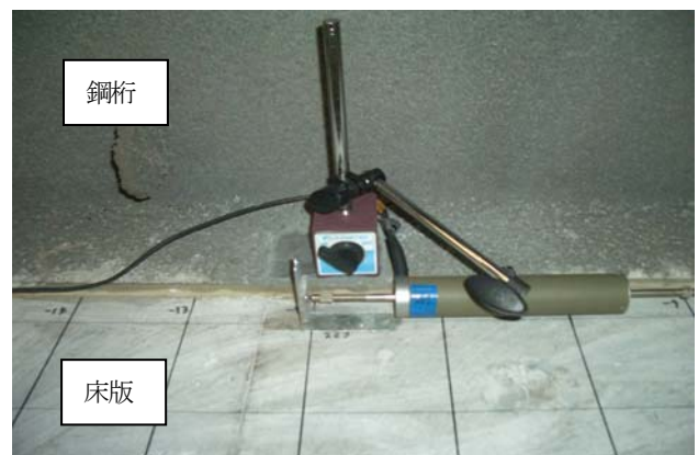
図－5 変位計の設置状況 (写真)
