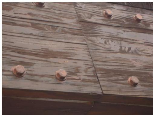
図-5 主桁外側の劣化状況（2006年）
