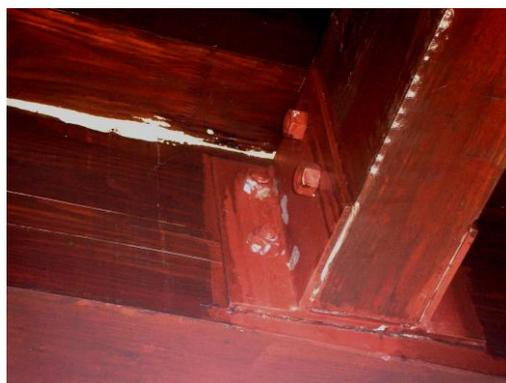
図-6 主桁内側カビなどの菌類繁殖（2006年）
