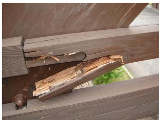
図-7 手すり部の部材欠損（2006年）
