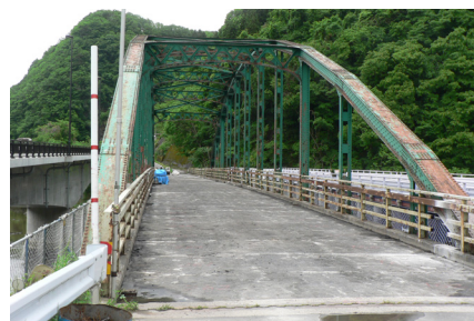
図-2 撤去された鋼ランガー橋（撤去前）
