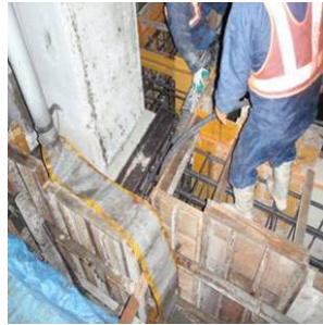
(コンクリート打設)
