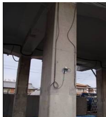
写真-4 柱への加速度センサー取付け状況
