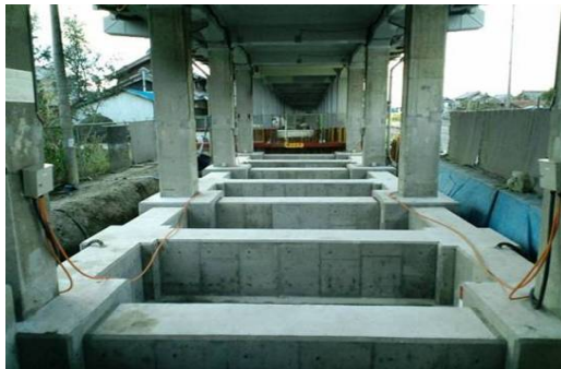
写真-3 地中梁完成時の状況
