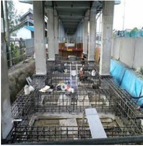
(地中梁鉄筋組全景)
