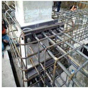
(地中横梁と柱周り鉄筋組)
