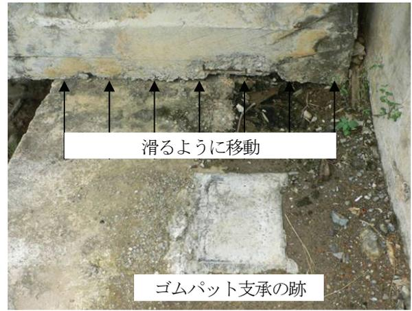
写真-1 桁面と橋台間の代表的損傷
