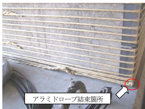
写真-1 アラミドロープの定着状況
